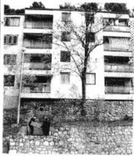
Treba prohodati 95 stepenica i doći na 3. kat
